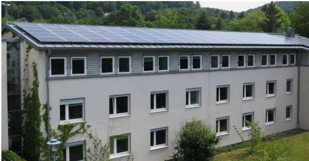
Im Hermann-Jacobsohn-Weg hat die EGMB eine Photovoltaik-Anlage installiert, deren gewonnener Strom überwiegend direkt im Haus verbraucht wird. (Foto: Sonja Minke)
